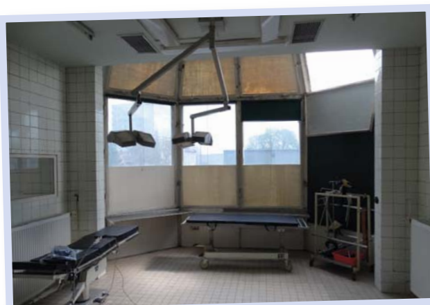
Původní nemocniční prostory, ve kterých vznikne nové dialyzační středisko
