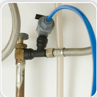
Adaptador para la parte inferior del lavabo
