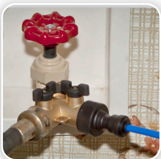
Adaptador de conexión para la lavadora
